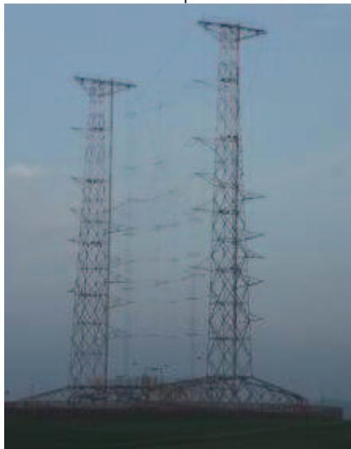
En effet de part et d'autre, on trouve d'un côté du rideau l'antenne **A** (de 9 à 15MHz) avec 8 dipôles organisés en 2 fois 4 superposés et l'antenne **B** (de 15 à 21MHz) organisée selon la même architecture.
